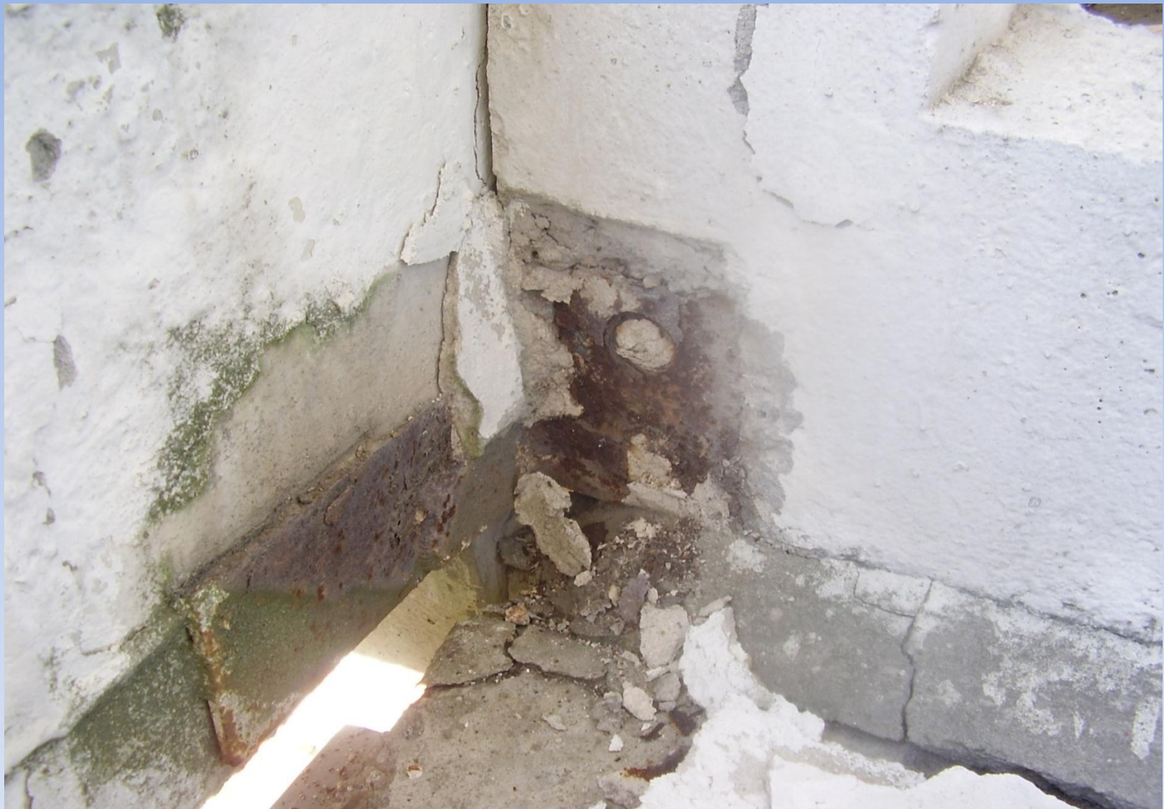
Ржавая закладная деталь, к которой крепится ограждение лоджии
