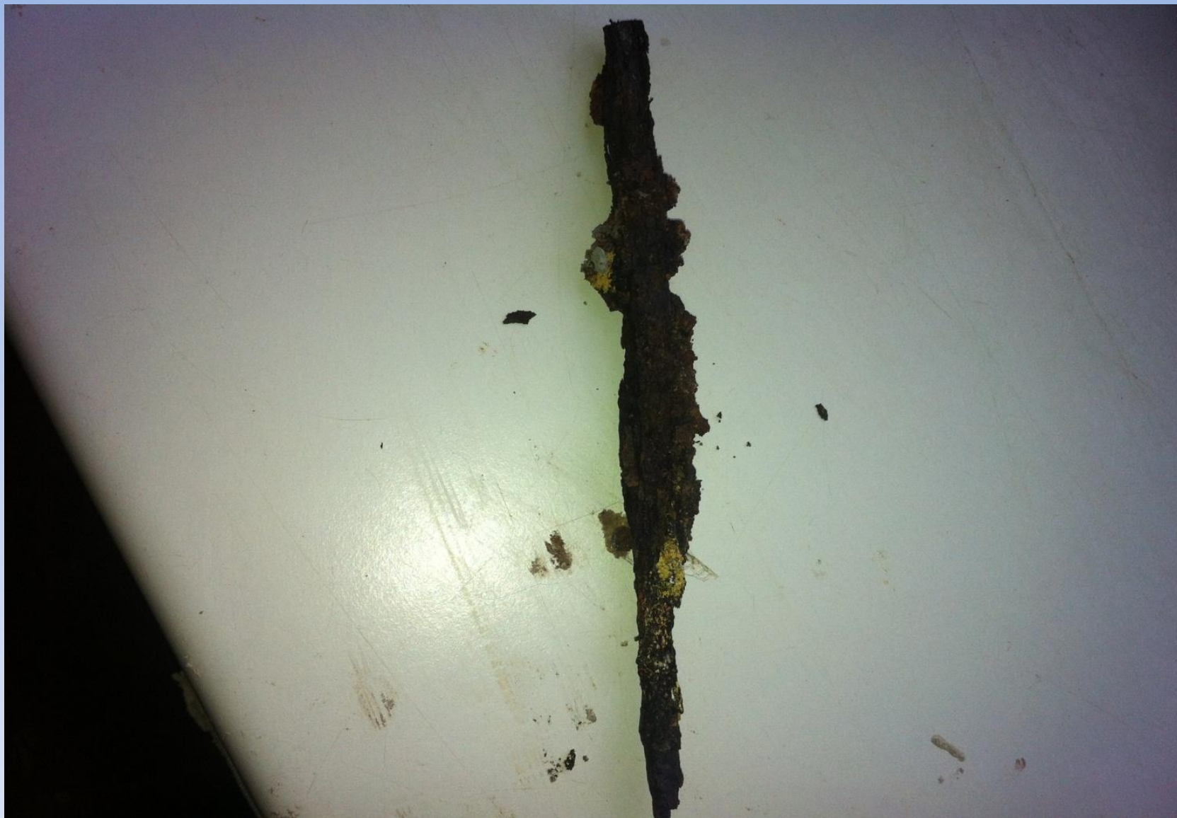
Проржавевшая арматура, извлечённая из бетона
