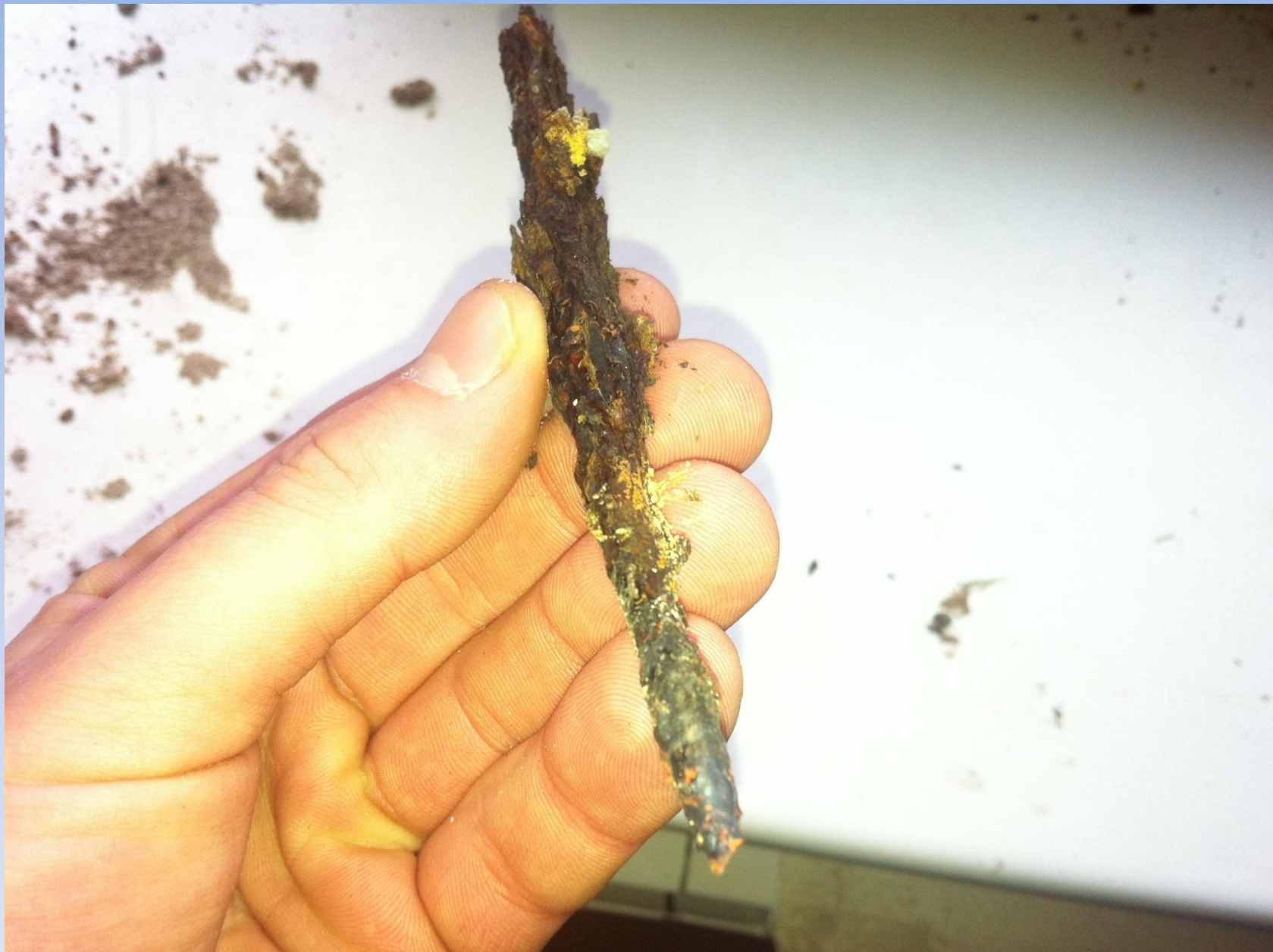
Проржавевшая арматура, извлечённая из бетона
