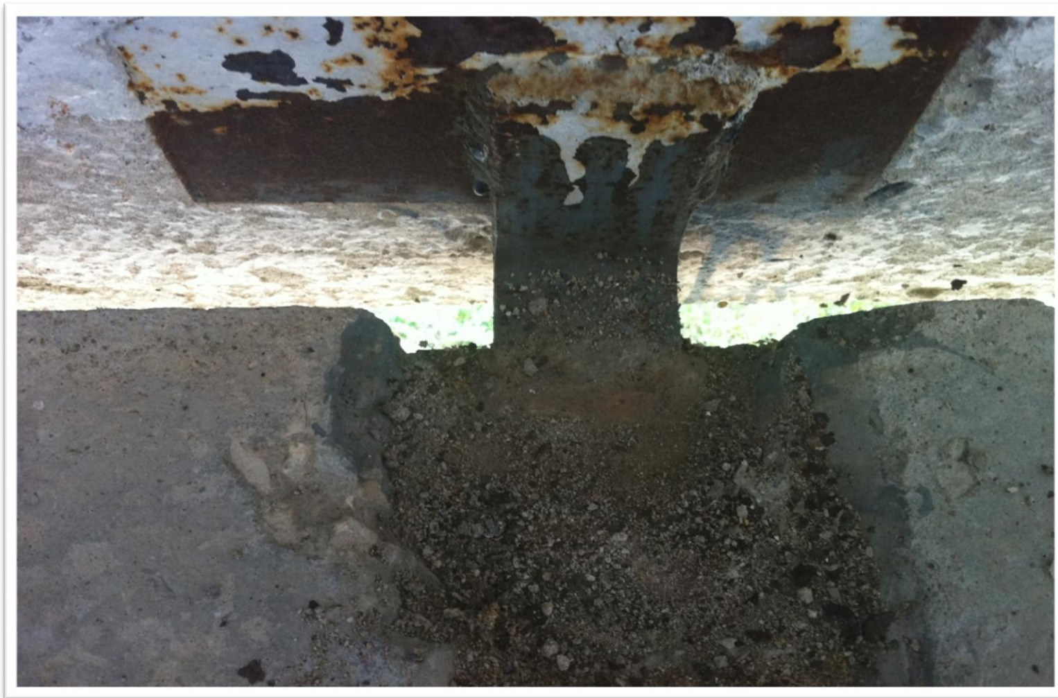
Korrodeerunud ühendused
