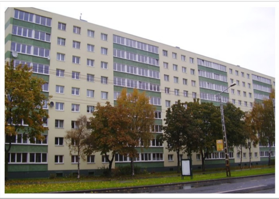
Analoogne hoone, mis on renoveeritud energiasäästu programmi järgi. Teostatud tööd: Fassaadi ja katuse soojustus ja akende vahetus. Kütte maksumus 1 m 2 - 0.96 eurot kuus
