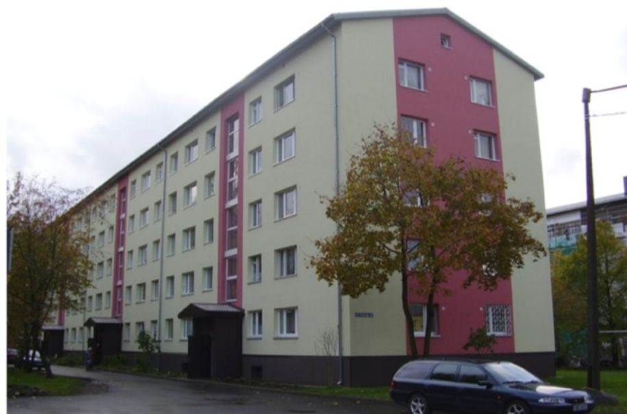
Analoogne hoone, mis on renoveeritud energiasäästu programmi järgi. Teostatud tööd: Fassaadi ja pööningu soojustus, akende vahetus, ventilatsioonisüsteemi korrastamine. Kütte maksumus 1 m 2 - 0.96 eurot kuus
