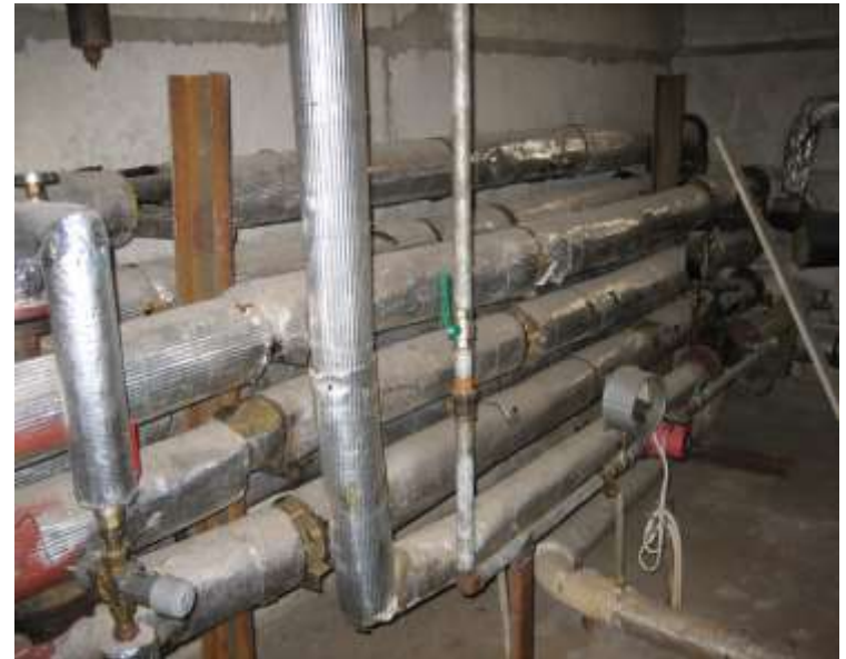
Vana küttesüsteem (vana kuumavee soojavaheti näidis)
